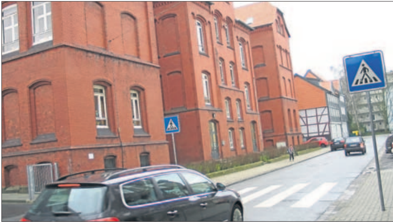
Die Grundschule Karlstraße soll saniert werden. Eines der Ziele lautet dabei Energie zu sparen. Wie weit das die Backsteinfassade erlaubt, soll noch geprüft werden. Foto: Kai-Uwe Ruf
